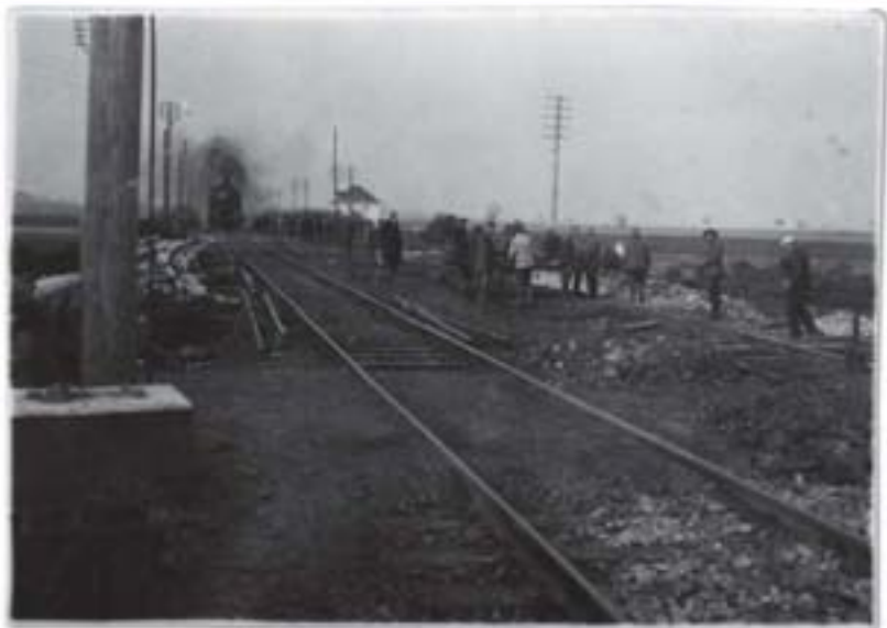
2| Bauzug bei Umspurarbeiten, Nähe Swerdlowsk, Russland
