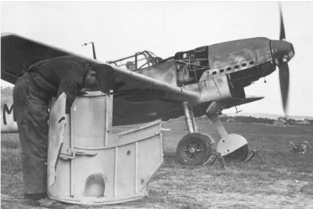
*An einer Bf 109 D wird ein Testlauf des Motors nach einer Reparatur durchgeführt. Im Vordergrund überprüft ein Flugzeugwart die obere Abdeckung. (Foto: Sammlung Peter Schmolli)*
