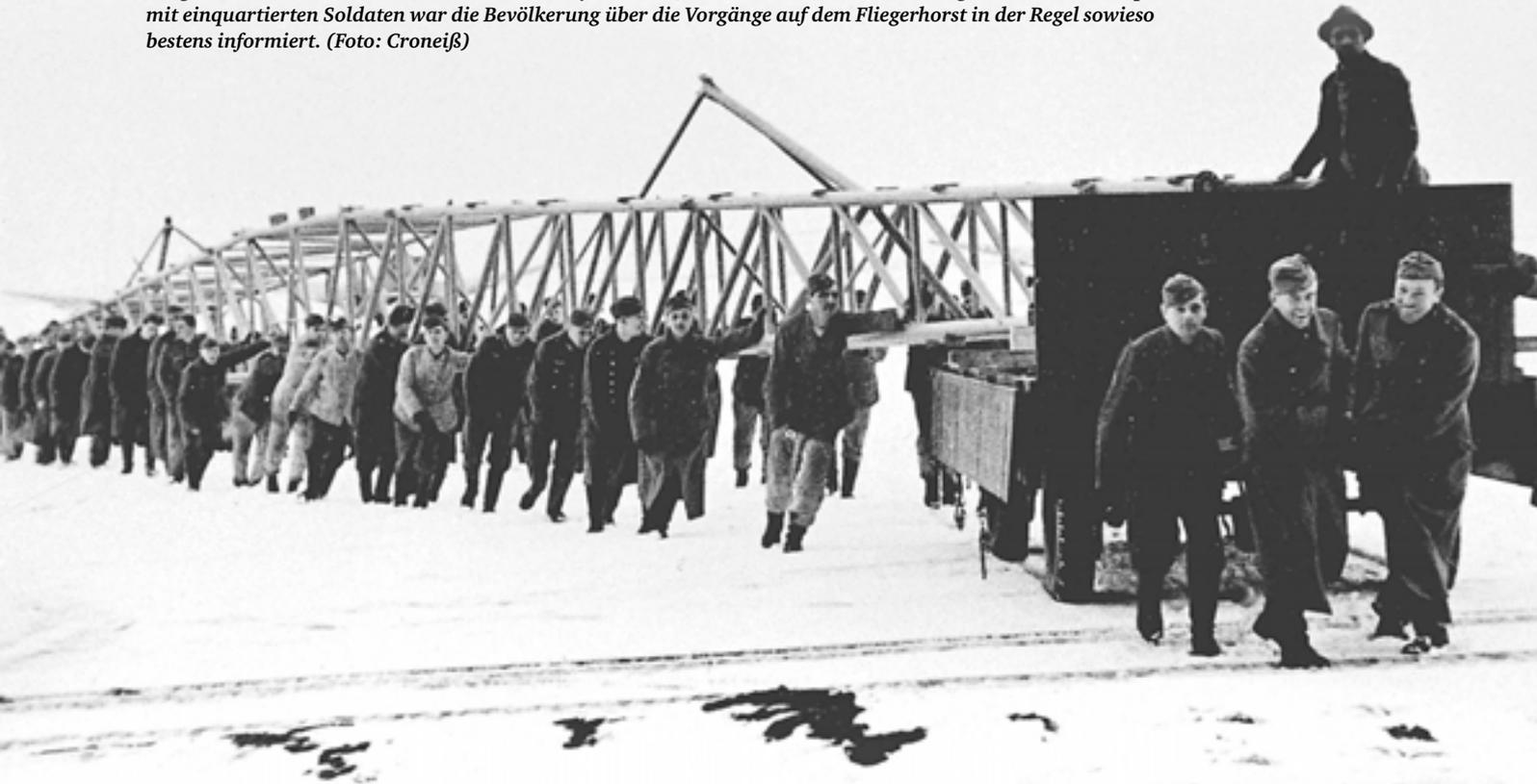
*Im Januar 1941 erfolgte die Anlieferung der ersten Tragflächenholme für die Me 321 auf den Fliegerhorst. Bereits bei diesem Bild kann man beim Vergleich des Holmes mit den Luftwaffensoldaten erkennen, welche gewaltigen Dimensionen dieser Lastensegler hatte. In diesem Fall liegt der Holm mit der Oberseite auf den Transportanhängern auf. Deutlich sind die nach oben ragenden Streben zu erkennen, mit denen später die Tragfläche an der Unterseite zum Rumpf hin abgestrebt wurde. (Foto: Croneiß)*
